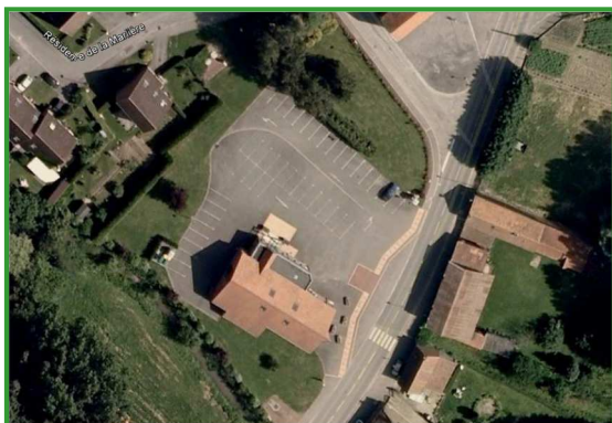
Réfection de l'accessibilité et la mise aux normes PMR de la Salle des Fêtes
